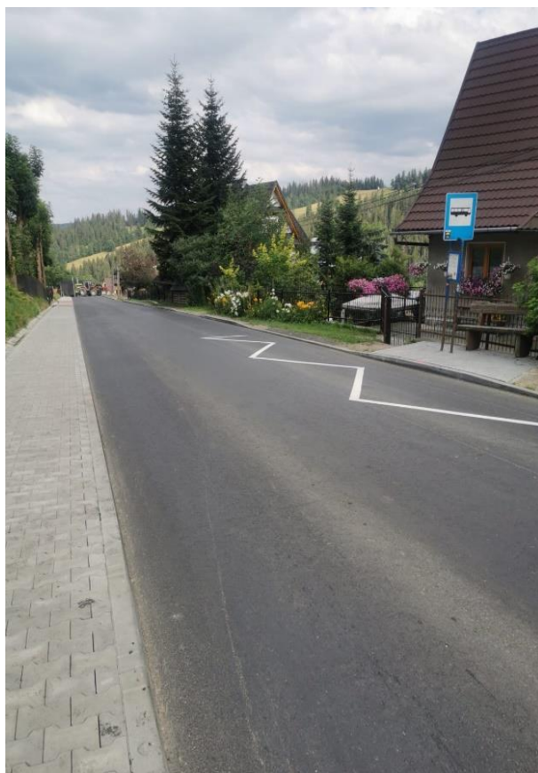
Przebudowa drogi - Suche 2
