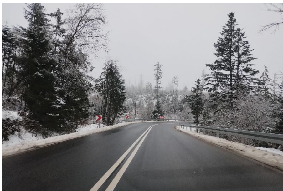
Przebudowa drogi Oswalda Balzera
