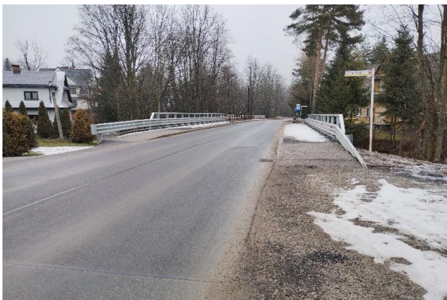
Rozbudowa mostu - Leśnica 1
