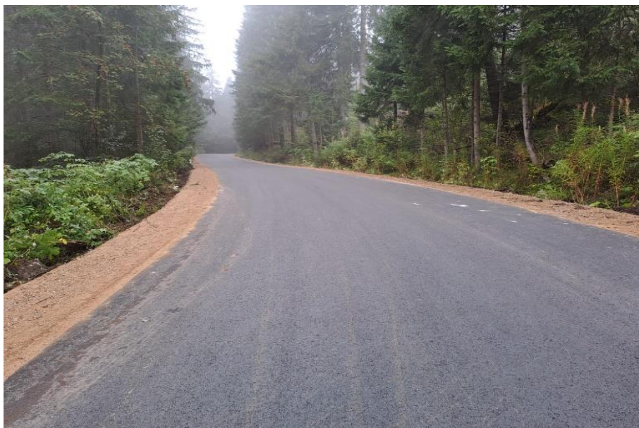
Remont drogi Łysa Polana - Morskie Oko
