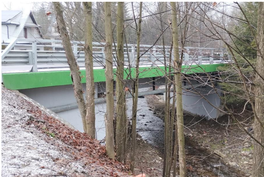
Rozbudowa mostu - Leśnica 2
