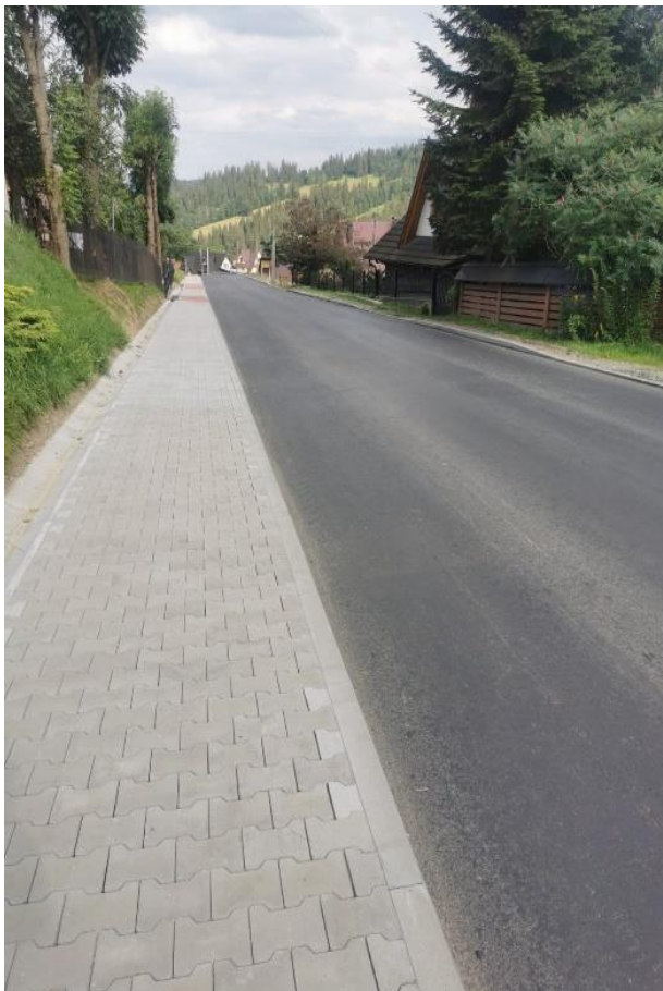
Przebudowa drogi - Suche 1
