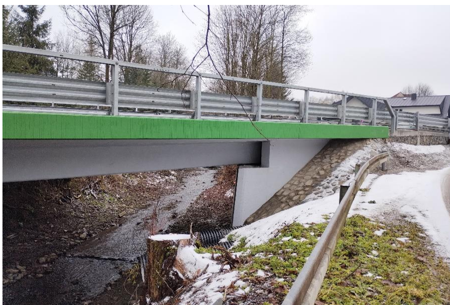
Rozbudowa mostu - Leśnica 3
