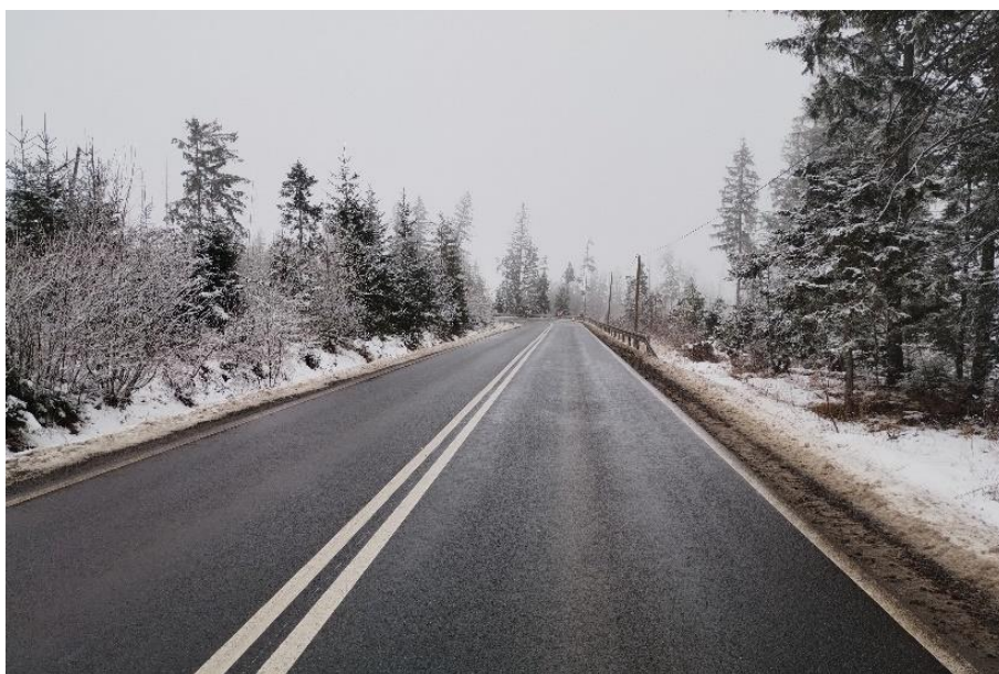
Przebudowa drogi Oswalda Balzera
